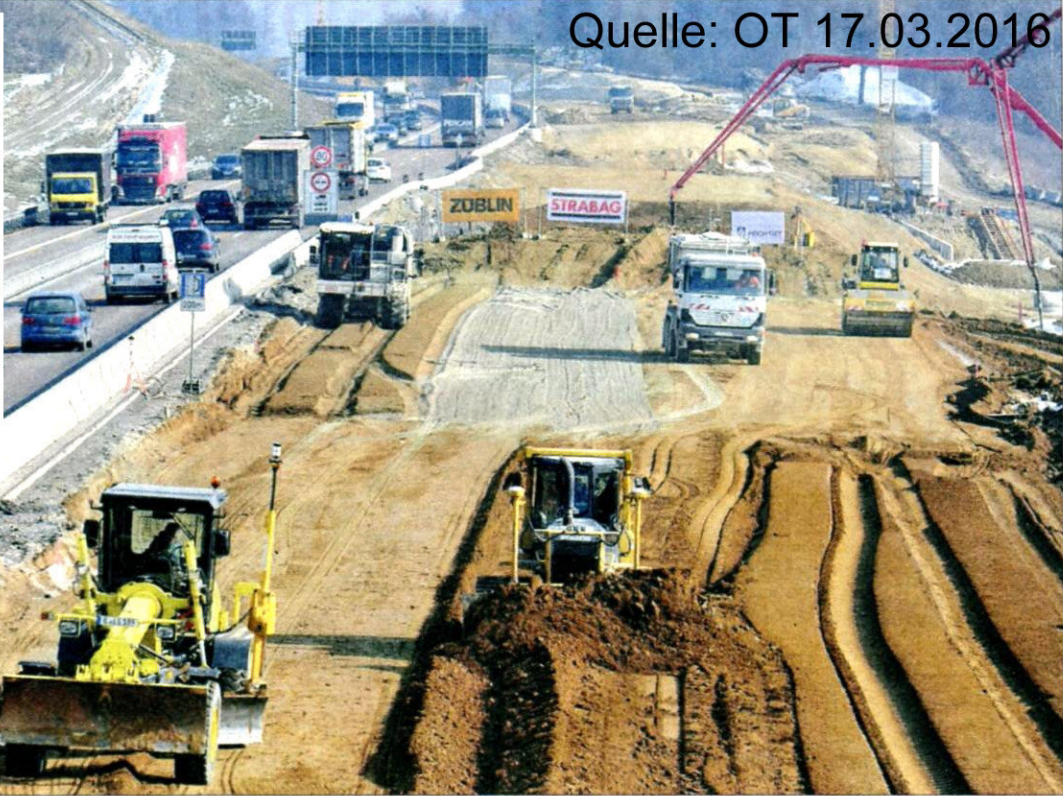
Baustelle an der A8 zwischen Augsburg und Ulm.
